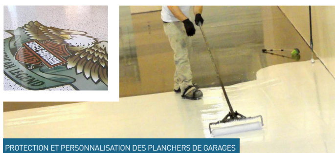
PROTECTION ET PERSONNALISATION DES PLANCHERS DE GARAGES
